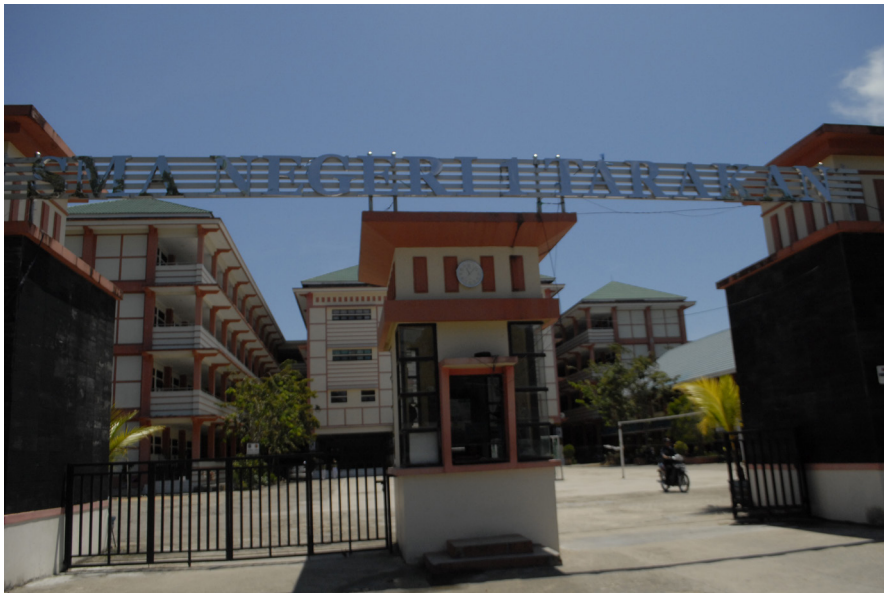
Bangunan SMAN 1 Tarakan
